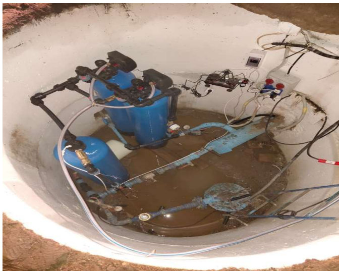
14 pav. Kazokinės nugeležinimo įrenginys
